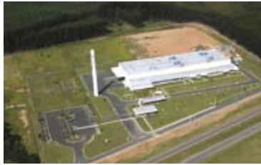
Unidade Filtros Mogi Guaçu
